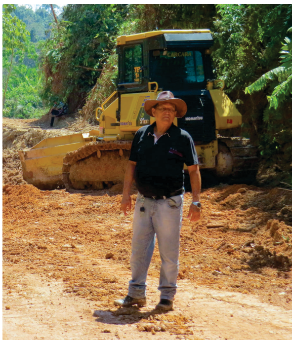
Execução de acessos nas áreas indígenas
